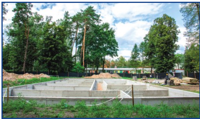
Budowa szkoły branżowej I stopnia w „Helenowie”
